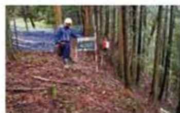
施工前の状況
