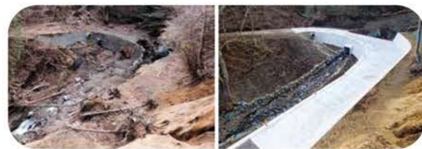
◀ 被災時の状況 ▶ 洗越工を施した林道 ▼ 当社作成の平面図
