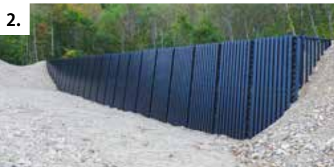
1. 施工前の被災地全景 2. 補強材を敷設した鋼製枠の導流堤
