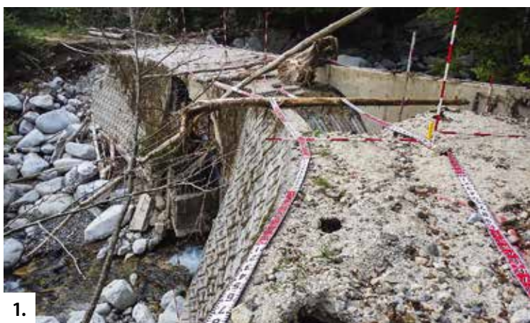
メイン写真。復旧した林道。終点側より。1. 同被災状況。2. 流失した路体。奥（終点側）の山側に擁壁工がある。3. 被災したコルゲートパイプ。
