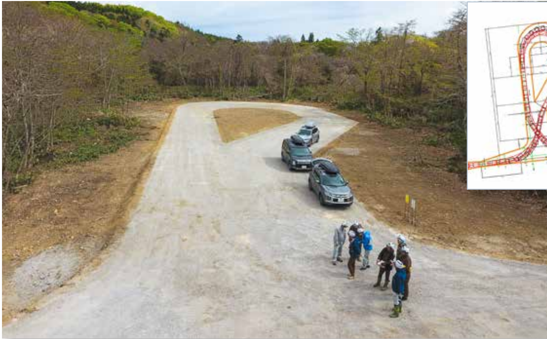
右) セミトレーラ旋回タイプ車廻し。左) 車両軌跡図による検討。
