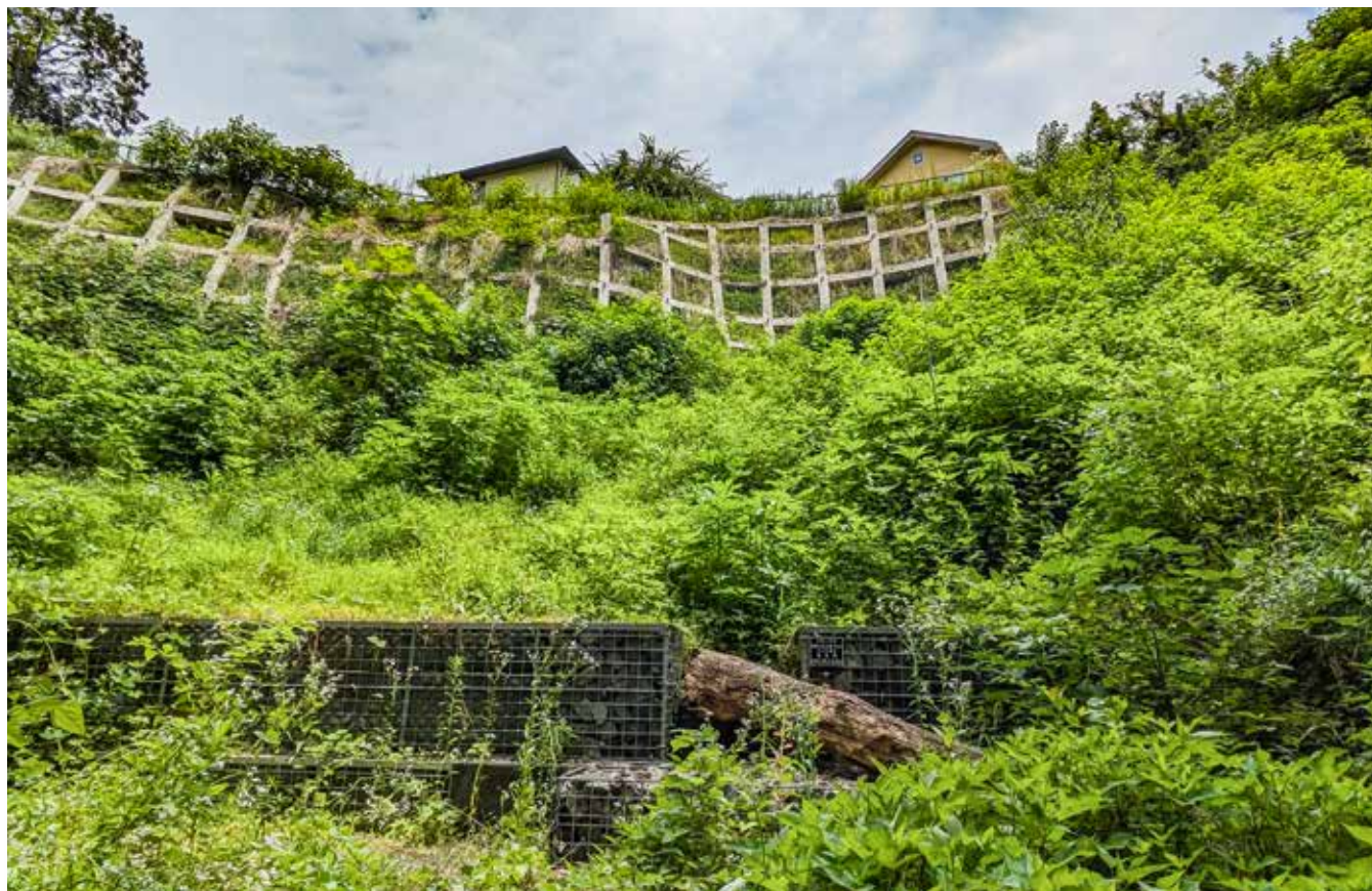
植生で覆われ斜面の安定が図られている対策工： 吹付のり砕工 + 鉄筋挿入工、土留工、筋工、伏工
