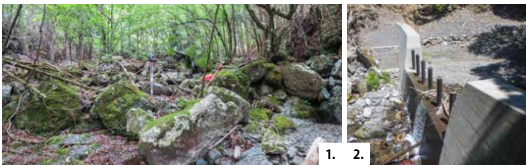
1. 施工前のダムサイト 2. ダム透過部
