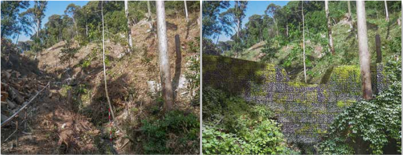
左) 荒廃溪流の調査時の状況。右) 治山ダム設置後の外観予想図。天然石残存型枠が苔むして周囲になじんでいる。
