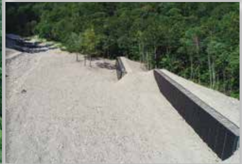
左) 施工完了時の全景(令和4年)。 4基の床固工と2基の導流堤。 右上) 上流側より導流堤を望む。 右下) 下流側より導流堤近景。
