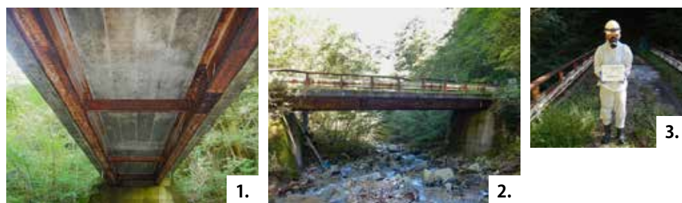
3. メイン写真。サンプリング作業進捗。 1. 橋梁桁下面（調査部分）。 2. 橋梁側面。3. 防護服着用状況。
