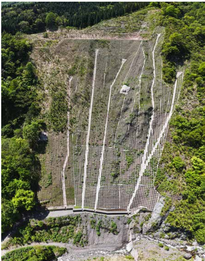
左) 施工後の山腹工全景。下部に土留工を配置し全面に簡易吹付のり砕工を施工。 右) 施工前。拡大崩壊により直下の溪流に土砂が流出した。
