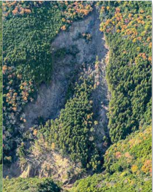
左) 令和5年度の施工状況 右) 災害発生時の崩壊地全景
