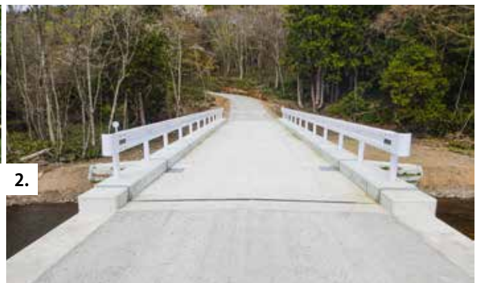
1. 老朽化した橋梁：老部川（おいっべがわ）に架設された老部川橋（昭和36年施工）。2. 新規橋梁：橋長L=22.2m 設計荷重245kN（A活荷重）鋼単純合成板桁橋。
