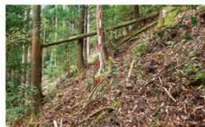
施工前の現場
