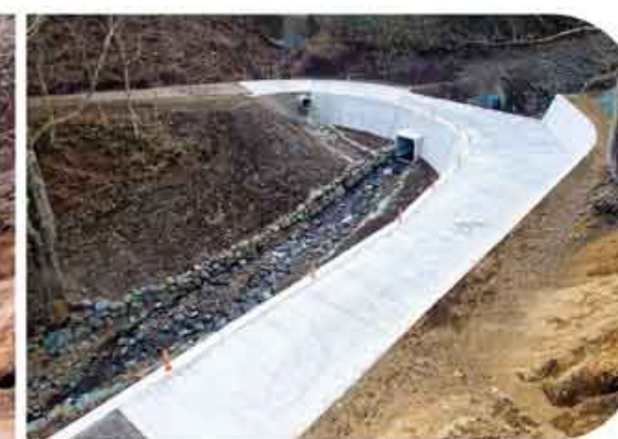
◀ 被災時の状況 ▶ 洗越工を施した林道 ▼ 当社作成の平面図
