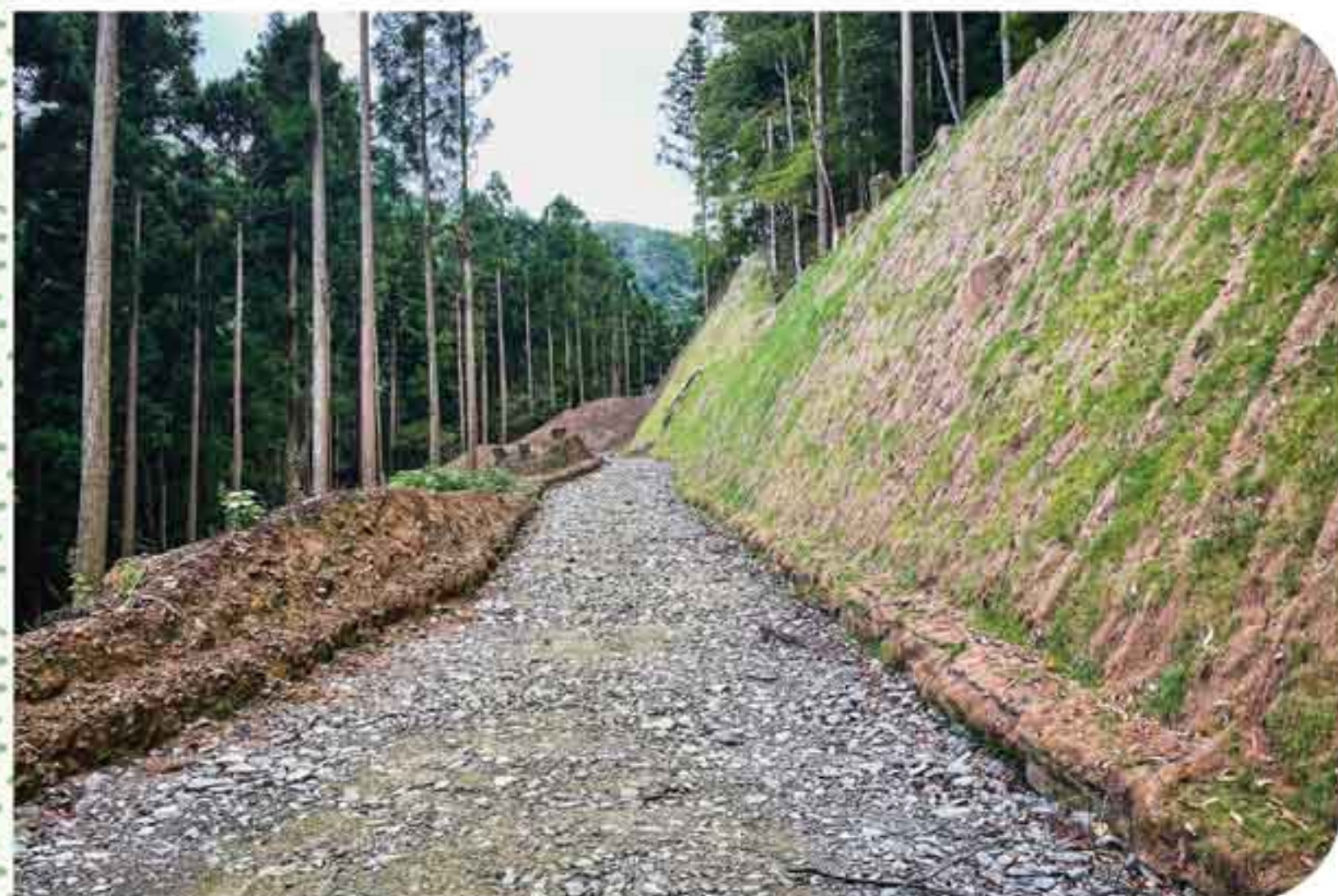
施工中の状況 (R4.8.)
