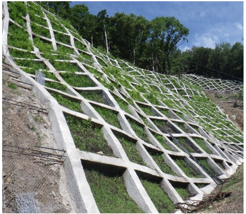
のり枠工 施工後 (H28.6)
