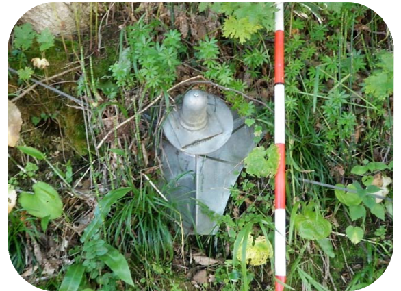
近傍のノンフレーム施工箇所
