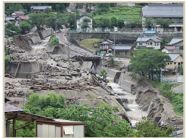
南木曾町被害状況
