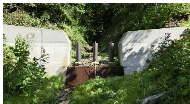
既設治山ダムの状況
