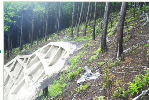
のり枠工とノンフレーム工 施工後 (H28.9)
