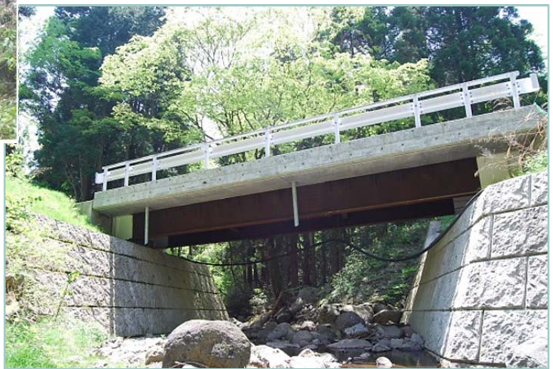
大矢橋 架け替え後※上流より (H29.5)
