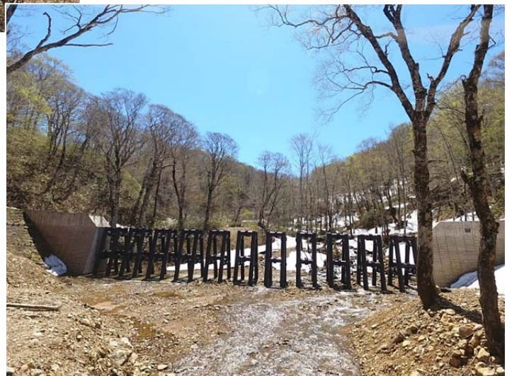
新設 鋼製スリットダム
