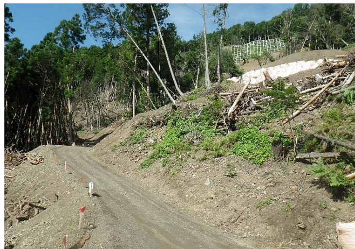
崩壊地内を通過する資材搬入路 (H28.6)
