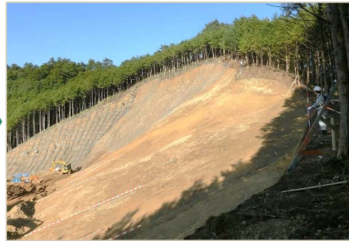
排土工 施工後 (H25.10)
