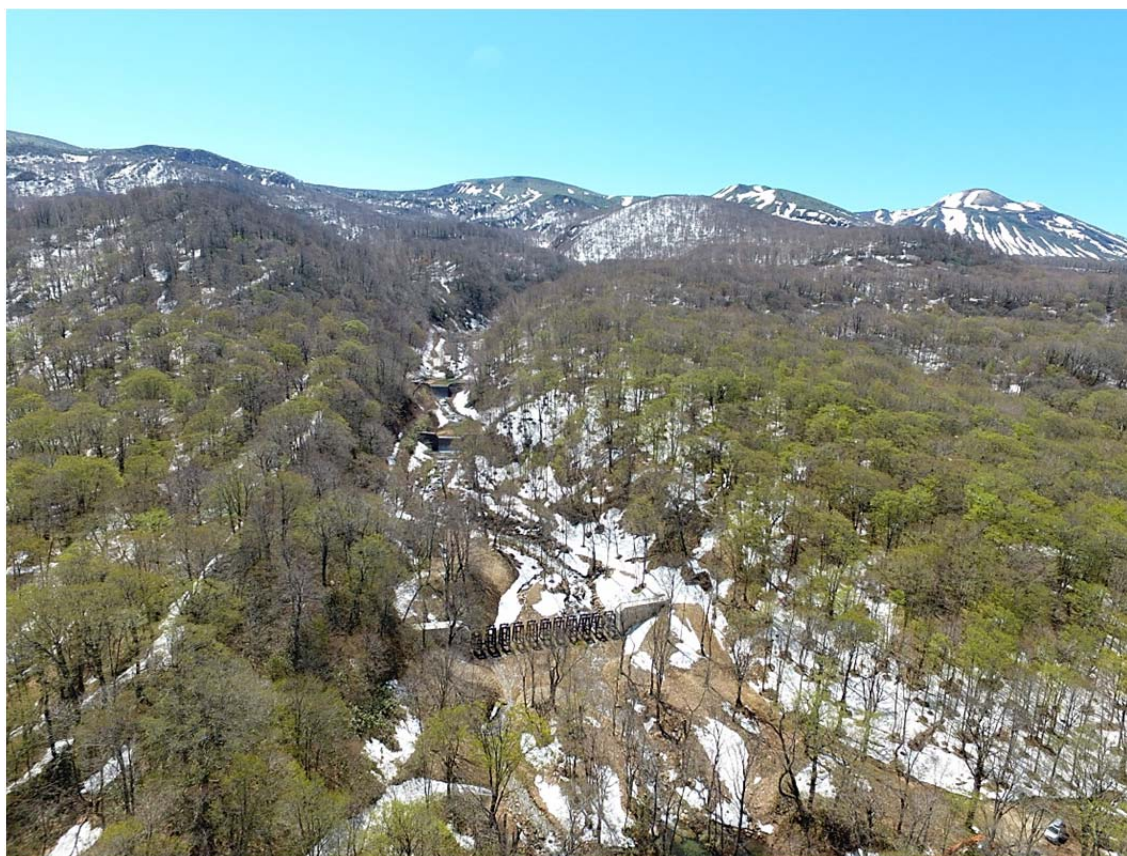
平成 26・27 年施工 鋼製スリットダムと後方秋田駒ヶ岳
