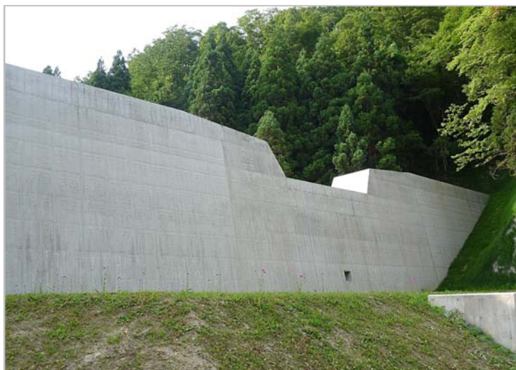
施工後 : 嵩上げ+増厚した土石流対応の治山ダム
