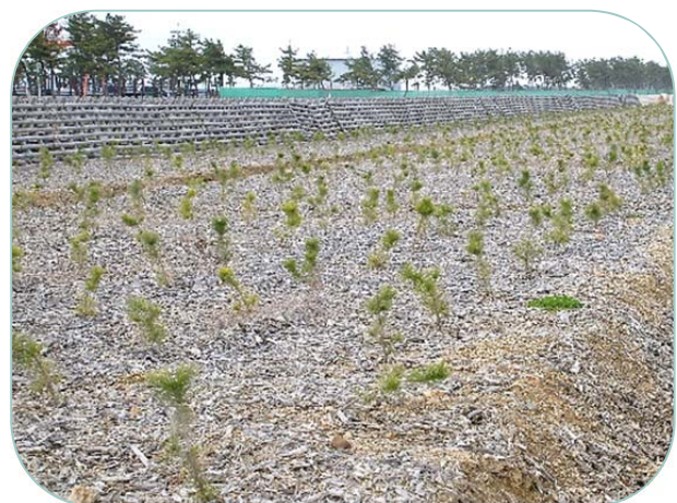
近隣工区の植栽後の状況
