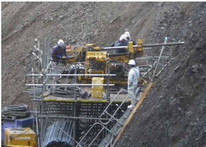
ボーリング暗渠工 施工中 (H27.12)
