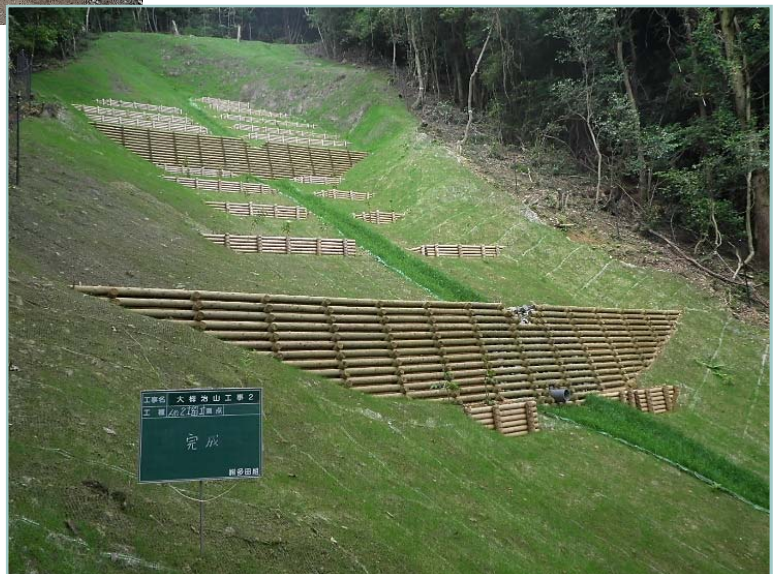
施工後 (No.2, No.3 土留工)
