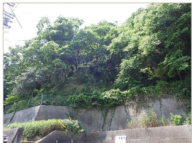
施工後の遠景
