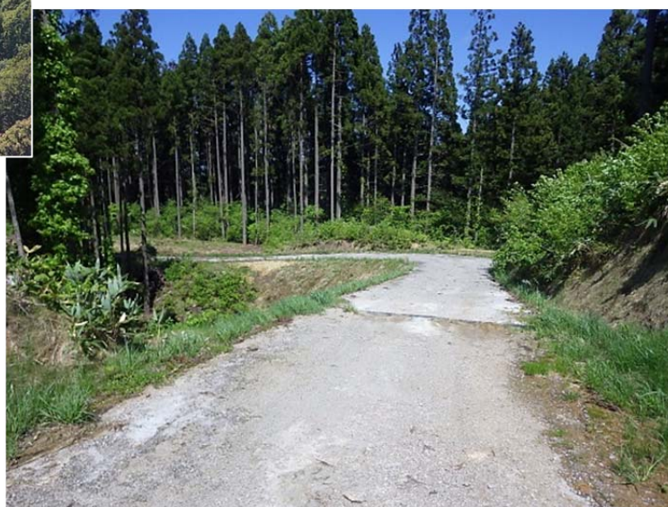
鉄鋼スラグ路盤工
