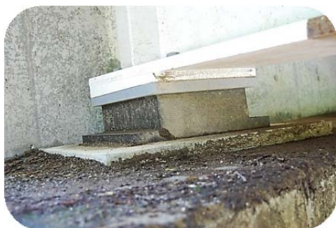
支承(ゴム)状況 (H29.5)
