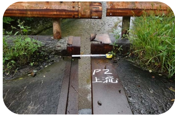
橋梁の破損状況
