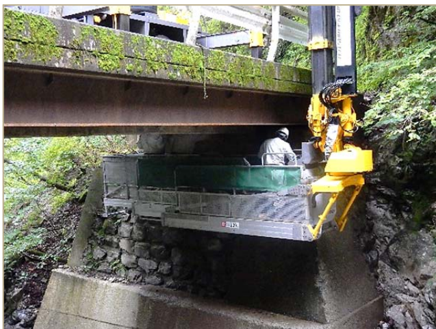
橋梁点検状況
