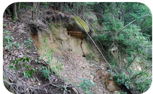
上部滑落崖の状況
