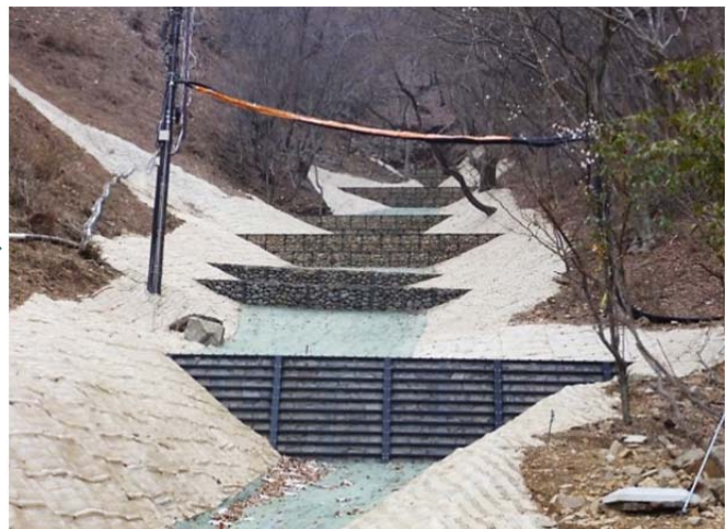
写真③: 施工後(平成 28 年 2 月)
