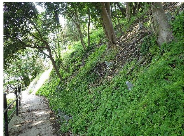
施工後の林内(直下に避難路)
