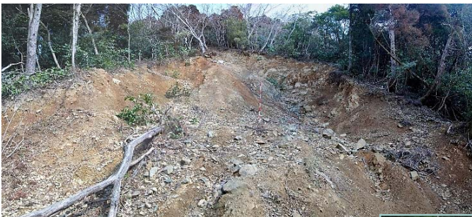
施工前(ポール位置は No.2 土留工計画箇所)
