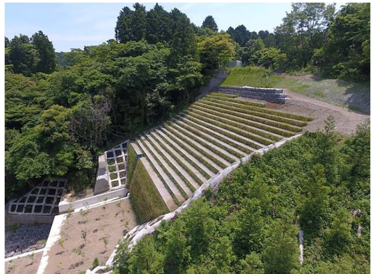
写真③: 施工後（平成 29 年 5 月）
