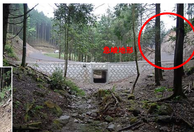
川西 3096 林道 竣工時 (H29.2)
