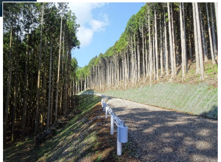
平成 28 年度工事で開設された箇所 切土勾配 1:0.8 盛土勾配 1:1.5
