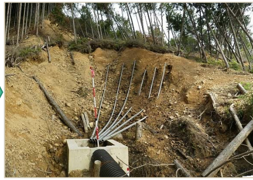
ボーリング暗渠工 施工後 (H24.6)
