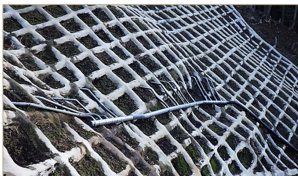
簡易のり砕工とボーリング暗渠工
