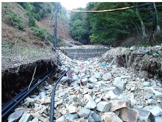
写真②: 施工前(平成 27 年 10 月)
