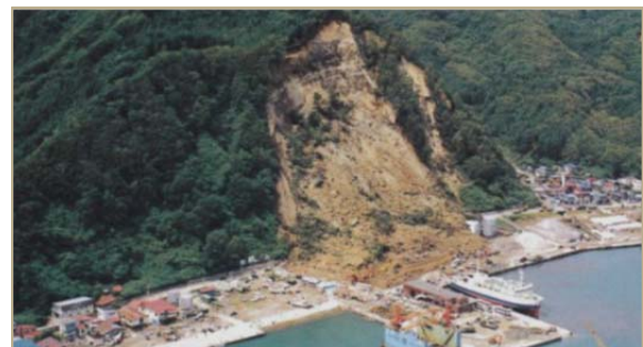
地震直後の状況
