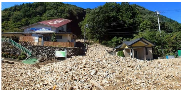
写真①: 崩壊直後の状況(平成 27 年 9 月)
