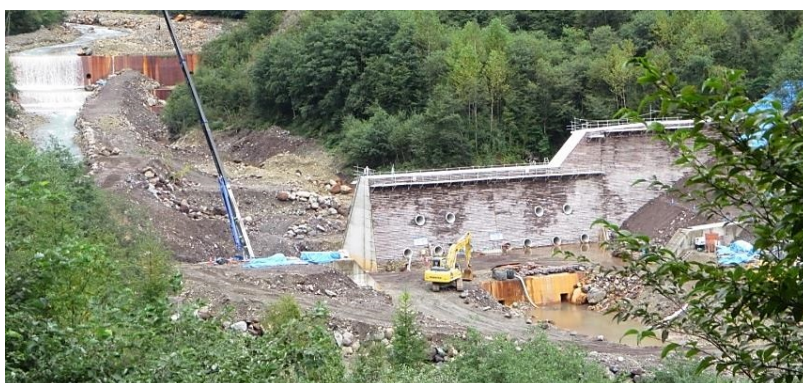
第 64 号コンクリート谷止工(施工中)
