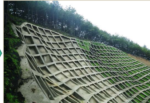
のり枠工 施工後 (H26.11)
