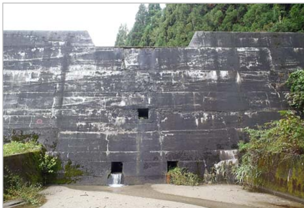
施工前 : 昭和 42～43 年施工の既設治山ダム
