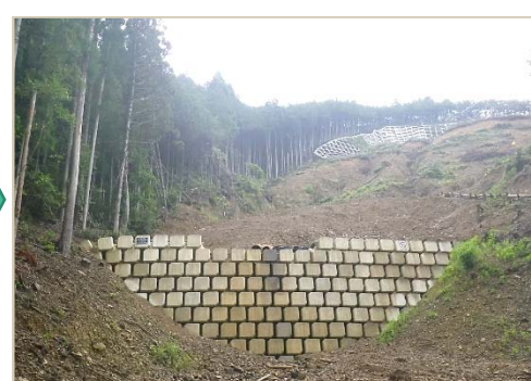
ブロックダム工 施工後 (H26.11)
