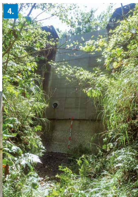
1. 保全対象の大路池 2. 3. 神着地区の調査対象施設。治山ダム（セルダム）の遠景と近景。 4. 5. 神着地区の調査対象施設。治山ダムと右岸間詰の洗堀状況。
