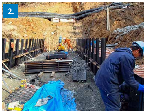
トップ写真：ダブルウォール工法の鋼製治山ダム 1. 施工前の被災状況 2. 施工中の様子
