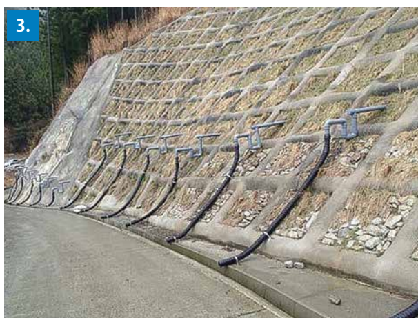
3. 斜面内部の有害な地中水を排除するボーリング暗渠工の地上出口付近の様子。これらに対応により、施工前には度々斜面の押し出しが発生し、直下の重要な地方アクセス道が損壊するなどの影響の出ていた不安定斜面は、現在安定を保ち通行が確保されている。4. 紀伊半島大水害直後の施工地周辺の様子。
