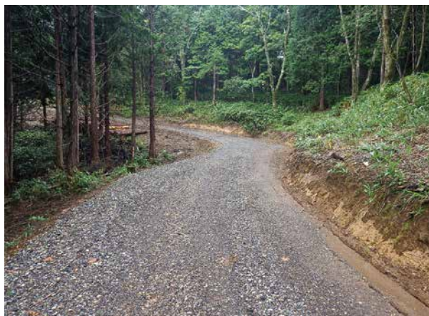
トップ写真：森林作業道とアクセスのよい、切盛のり高を低く抑えた道。下：切盛土量の均衡を図った路線計画。
