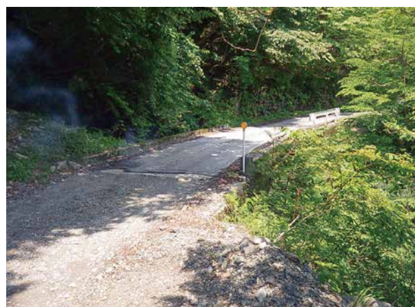
トップ写真：施工後の調査地の状況。急勾配の溪流に架かる鋼桁橋。上：施工前の調査地の状況。
