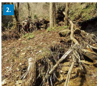
トップ写真：流木捕捉型のスリット構造 治山ダム 1. 施工前の被災状況 2. 施工前の 溪床内の不安定土砂 および流木の状況
