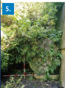
1. 保全対象の大路池 2. 3. 神着地区の調査対象施設。治山ダム（セルダム）の遠景と近景。 4. 5. 神着地区の調査対象施設。治山ダムと右岸間詰の洗堀状況。
