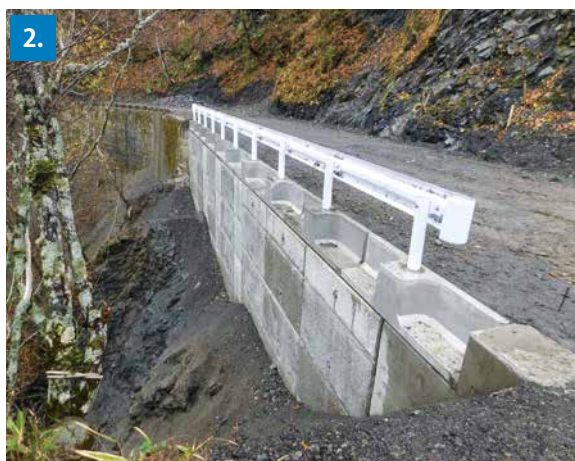
トップ写真：上空より擁壁を望む。 1. 床掘の概略図。 2. 橋の起点側より。
