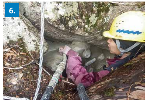
1. 斜面右側のオーバーハング 2. 足場設置状況 3. 斜面右側上部の浮石 4. 同位置の岩盤接着工 施工後の状況 5. 町道と施工地の位置関係 6. 岩盤接着工の施工状況
