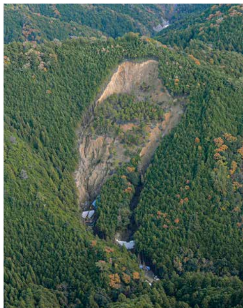
トップ写真：施工地の全景。 右：災害発生時の崩壊地全景。
