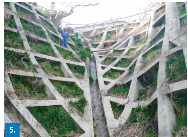
3. 崩壊斜面上部より下方を望む 4. 県産材の表面加工を施した土留工 5. 土壌を保全したのり枠工 6. 土留工周辺に植生が復旧した様子 7. のり枠工に植生が復旧した様子
