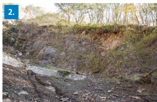
トップ写真：マイティーネット工を施工した崩壊地。（令和元年6月撮影） 1・2. 施工前の斜面の状況。（平成28年10月撮影）
