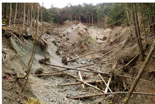
トップ写真：施工地全景。手前に木製土留工。のり面に植生マット工および木製のり砕工。左：施工前の被災状況。
