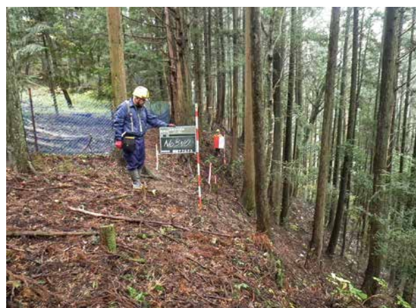
トップ写真：切取土量・切取のり面の削減を考慮した設計。 下：施工前の施工地の状況。
