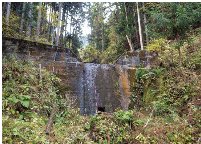
トップ写真：既設谷止工を嵩上げし鋼製スリットを施した治山ダム 左：施工前の状況
